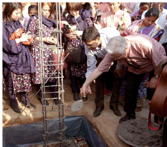
鍬入れ式で柱にセメントを入れる
